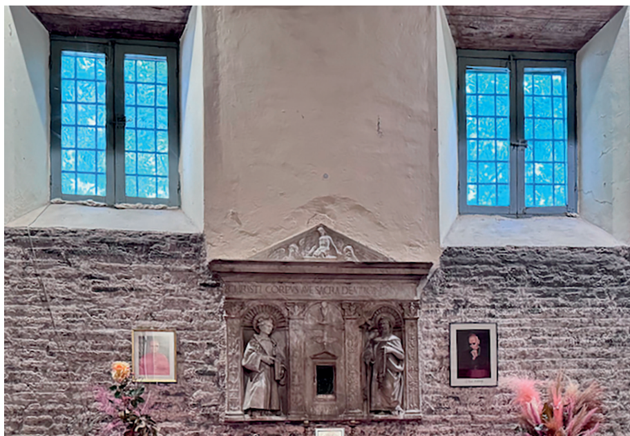
Auch die Fenster der Sakristei werden Bestandteil der Restaurierungsarbeiten sein ...
